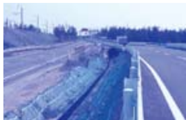
勝手橋の現況
