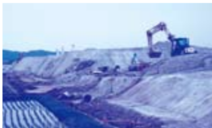
神宮寺バイパスの工事風景
